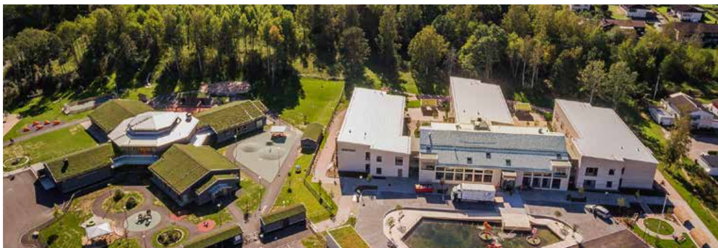
I juni 2018 färdigställdes Råsvägen (t.h.), särskilt boende med 54 lägenheter i två våningar.
