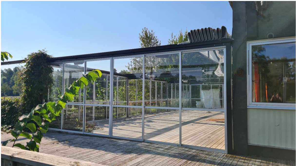
Foto september 2024. Taket är öppningsbart, öppet på bild.
