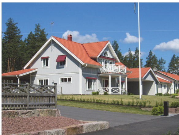
Befintligt hus vid Norrabyvägen norr om södra anslutningsvägen
