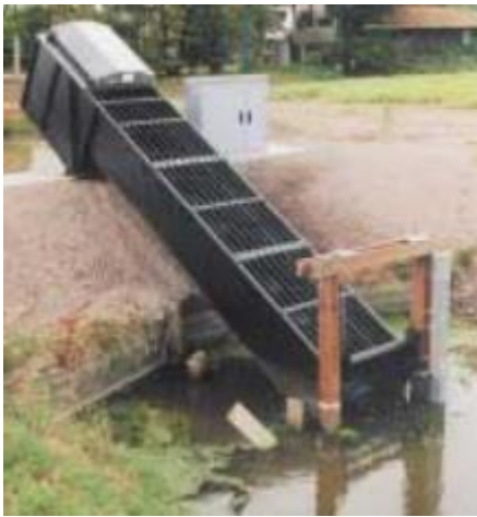
Figur 7. Exempelbild på prefabricerad snäckpump (Källa: Spaans Babcock)
