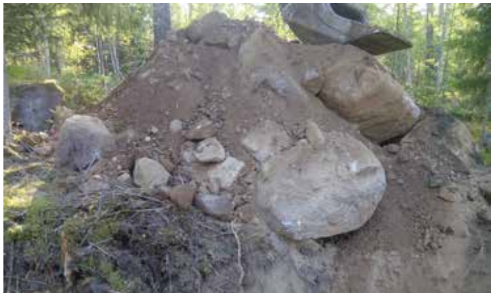
Bild 5. Schaktmassor från WPG4.
