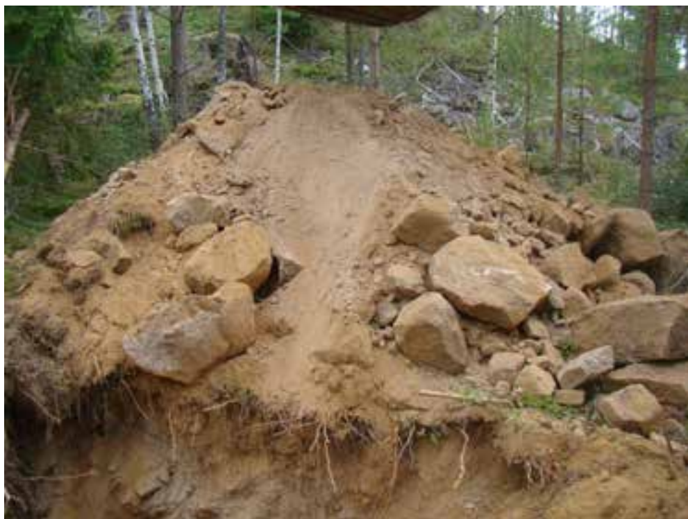
Bild 7. Schaktmassor från WPG10.
