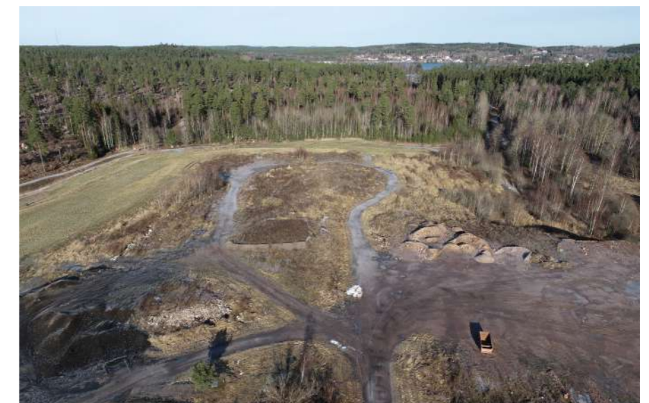
Drönarfoto tagen från toppen av deponi i riktning mot Skoboviken som skymtas i norr. Sluttäckta slätter till höger i bild (2023).
