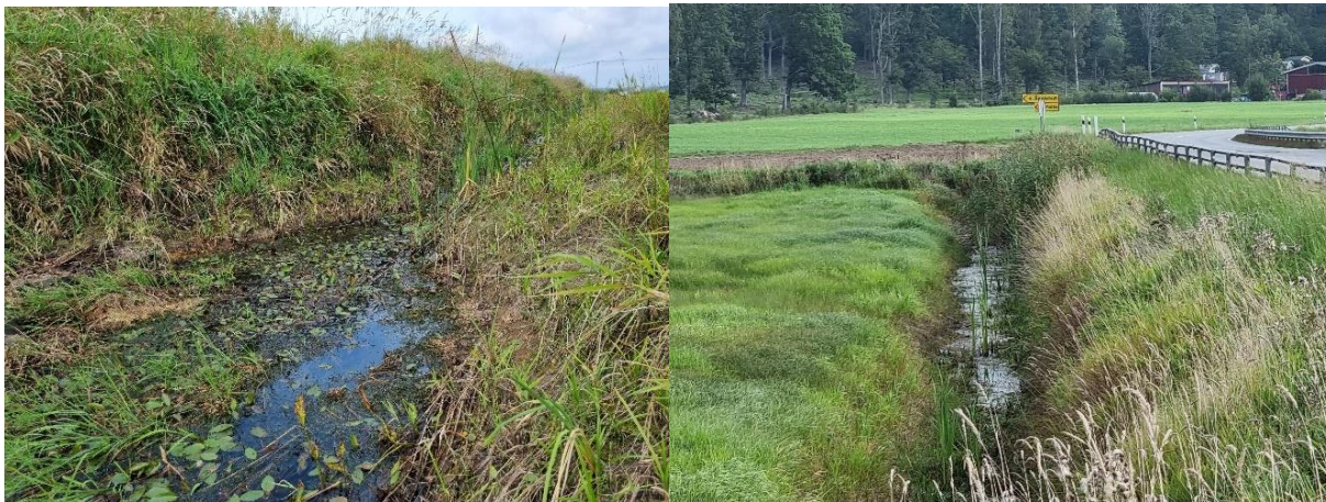
Figur 6. Till vänster diket parallellt med Adelövån med tydligt grundvattenutläckage. Till höger diket längs med Väg 133. Bilder tagna vid fältbesök 2023-09-12 (Foto Structor).
